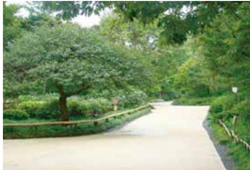
材料は自然素材「**真砂土**」にセメント少量と、「**真砂コン液**」を添加し水で練り、打設する土の特徴を活かした土間仕上げ材です。
