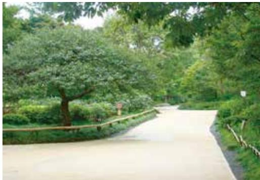
材料は自然素材「真砂土」にセメント少量と、「真砂コン液」を添加し水で練り、打設する土の特徴を活かした土間仕上げ材です。
