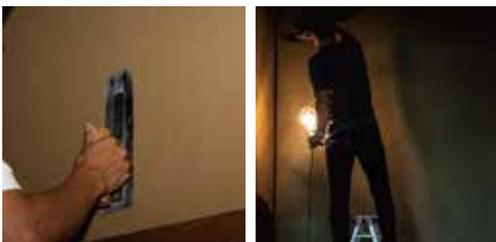
塗りつけ後、先丸の鋺等で撫で、鋺波を消し表面の肌を揃えていきます。あまり押さえ過ぎないように波を消す要領で壁面を撫でます。土の肌が見にくい場合は、ライトを当てながら鋺波を消して下さい。
