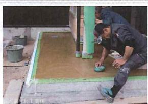
今回仕上げは、搔き落としの予定でしたが、予想以上の気温の低下により乾燥が悪く急遽スポンジ拭き取りに変更することになりました。塗り付け完了が午前11時頃なので15時頃には搔き落としが行えると考えていましたが予想以上に乾燥に時間がかかりました。研究室と相談し、冬場の乾燥スピードUPの検討が必要です。
