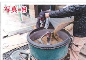
混練で重要なのはやはり入れる順番と硬さです。まずはミキサーに入れる順序ですが【写真-8】骨材1袋（17.5kg）と【写真-9】主材1袋（13kg）を入れ空合わせを行います。そこに【写真-10】標準水量4リットルを入れ混練します。
