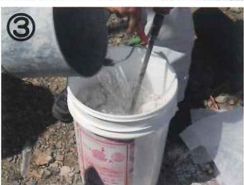
③固練りでダマを潰した後残り 1L の水を少しづつ入れ硬さを調節して下さい。
