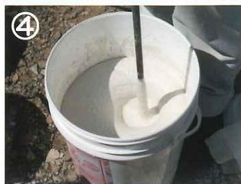
④加水をしながら硬さを調節し十分に混練して完成。
