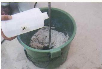
混練し適当な硬さに水道水で調整します。
