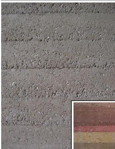
版築とは、コンクリートのような型枠に土を突き固めた工法で、主として土塀に多く利用されます。一定の間隔で積み上げ所定の高さまで突き上げていき、土と石灰と天然にがりを利用した土間たたき同様、セメントの無い時代より続く伝統工法です。
