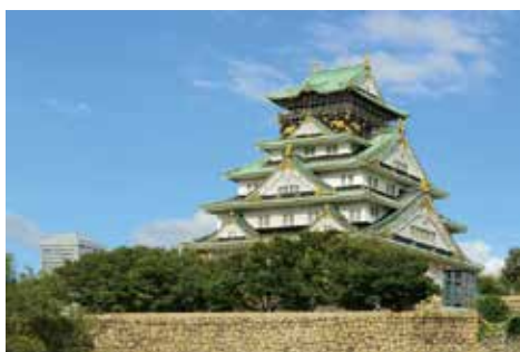
大阪城改修工事に使用
