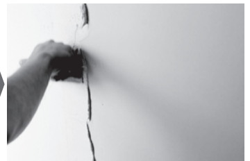
④ボードベース Light 全面塗り
