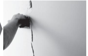
薄く平滑に全面に塗り付けます。
