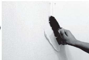
薄く平滑に全面に塗り付けます。
